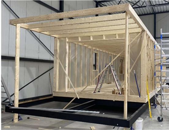
Oosthuis starterswoning in aanbouw
